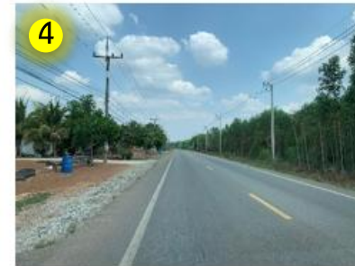
จุดตัดถนน อบจ.ฉช.3017 กม.109+665
