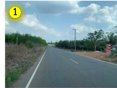
จุดตัดถนนท้องถิ่น กม.99+425
