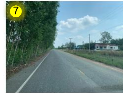
จุดตัดถนนท้องถิ่น กม.119+065
