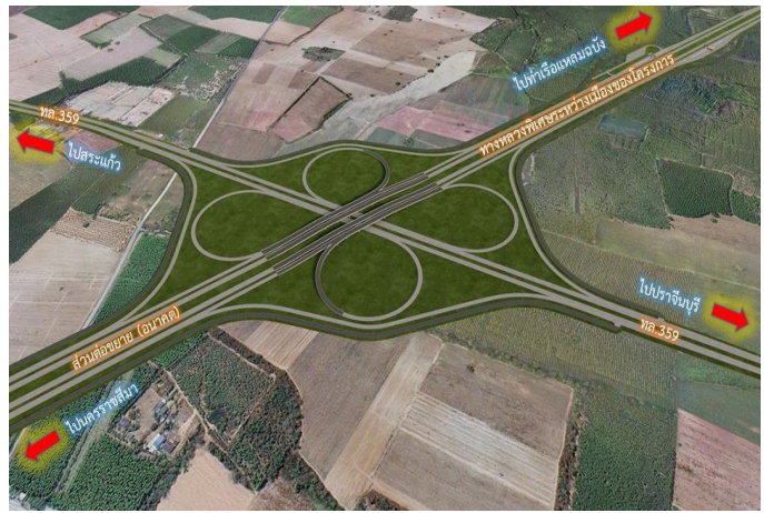
รูปที่ 7-11 รูปแบบทางเลือกที่ 2 Cloverleaf Interchange
